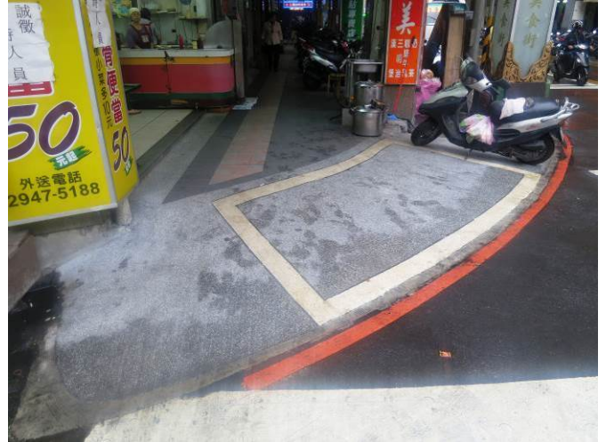
改善後，斜坡順平（標線重繪）
