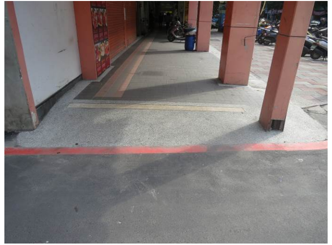
改善後，騎樓墊高，水往外排出
